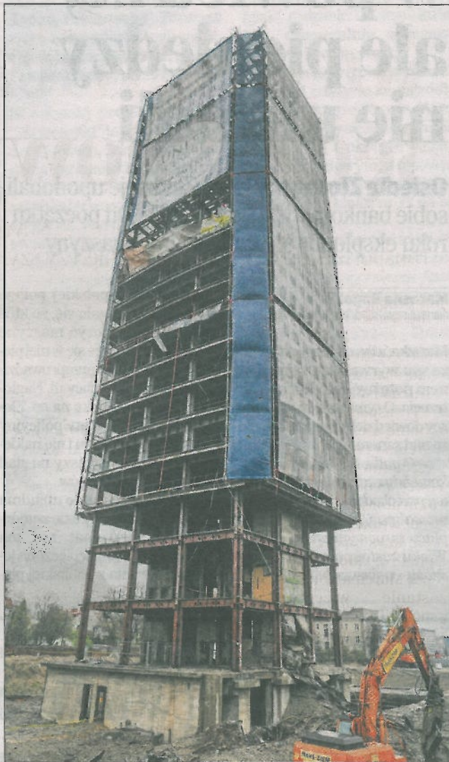
Obecnie skuwanie betonu trwa na 14. piętrze wieżowca
